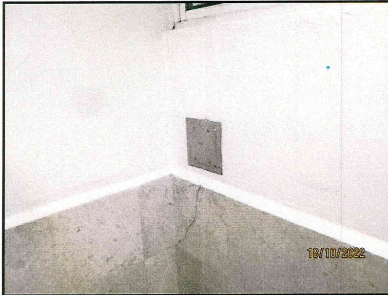
Foto 9. Fisuramiento de cerámico (azulejo) en zona de baños, en intersección de muro no estructural y columna (Vista Interior baño de mujeres)
