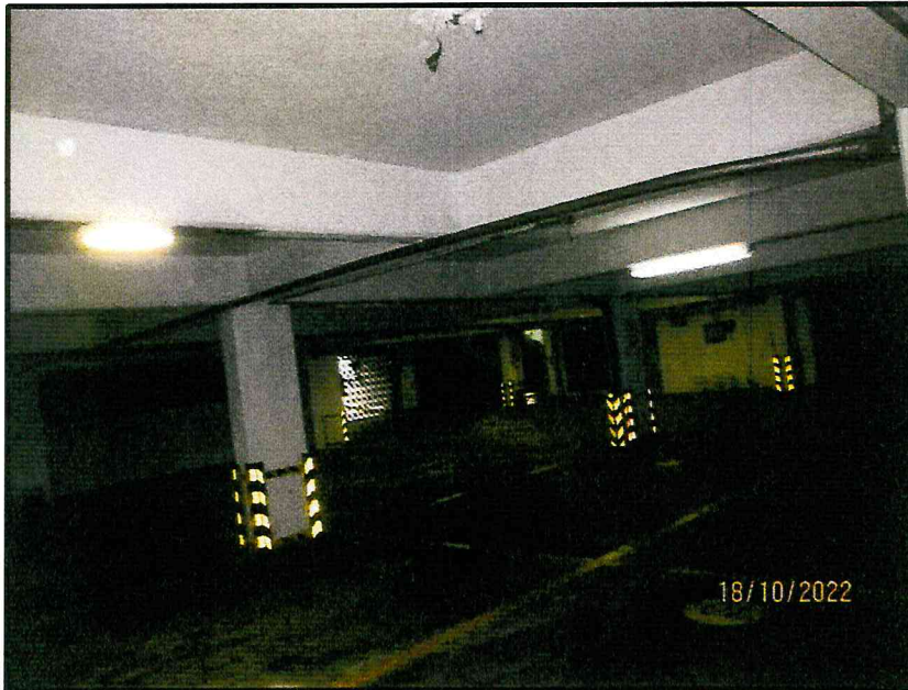
Foto 5. Planta Baja. Tablero con trabe intermedia
