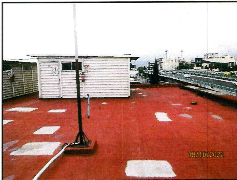
Foto 16. Zona de Azotea (Casetas y pararrayos).
