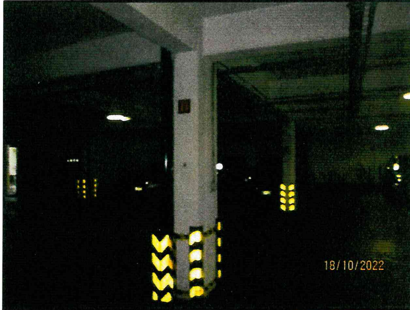
Foto 3. Marcos rígidos de concreto reforzado, altura entrepiso h= 2.60 m
