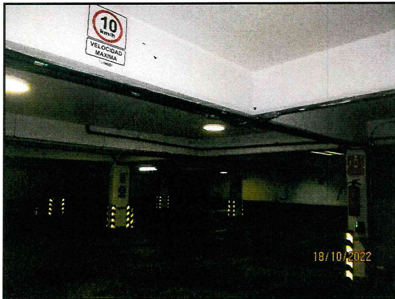
Foto 6. Planta Baja. Tablero con trabe intermedia
