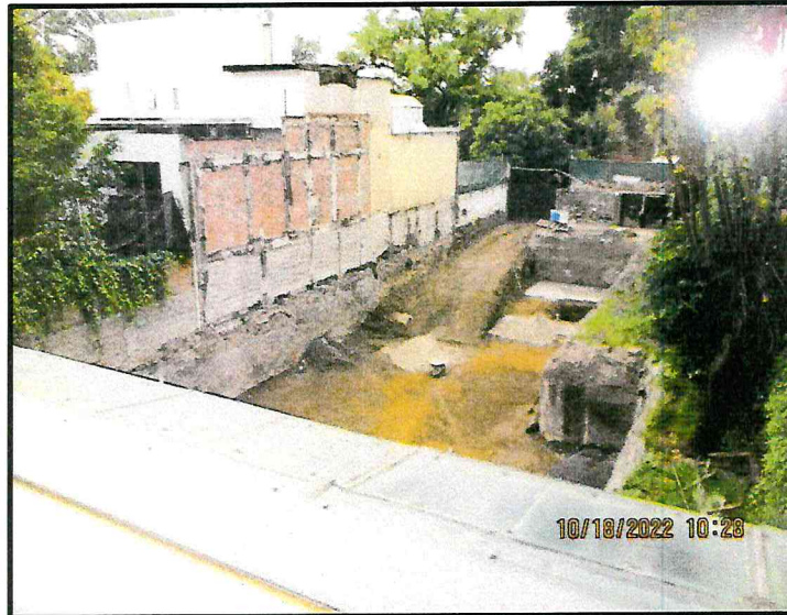
Foto 19. Obra nueva en colindancia Oriente. Se tiene que revisar la protección a colindancia.
