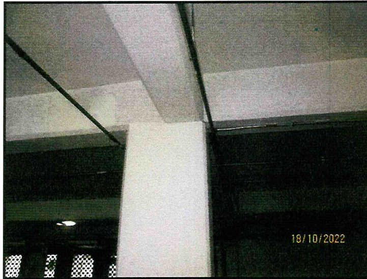
Foto 1. Área de Semi Sótano
