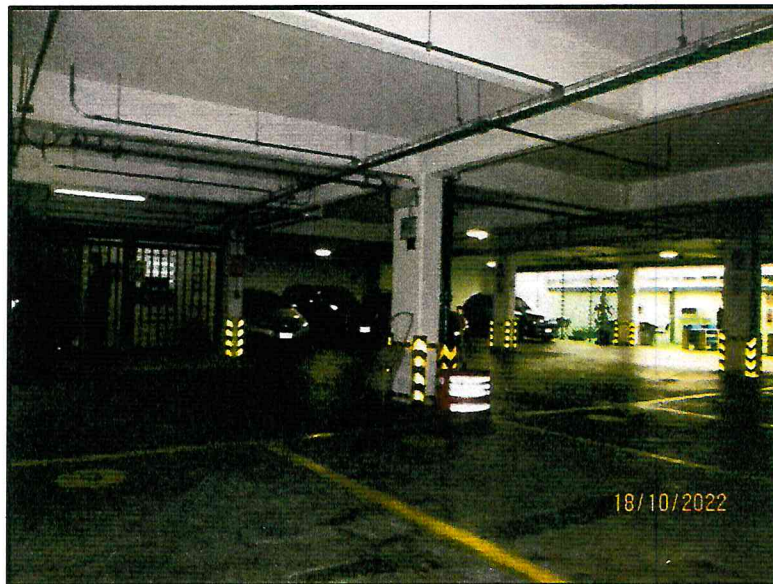
Foto 4. Planta Baja. Área de estacionamiento
