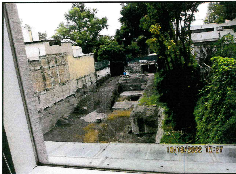
Foto 19. Obra nueva en colindancia Oriente. Se tiene que revisar la protección a colindancia.
